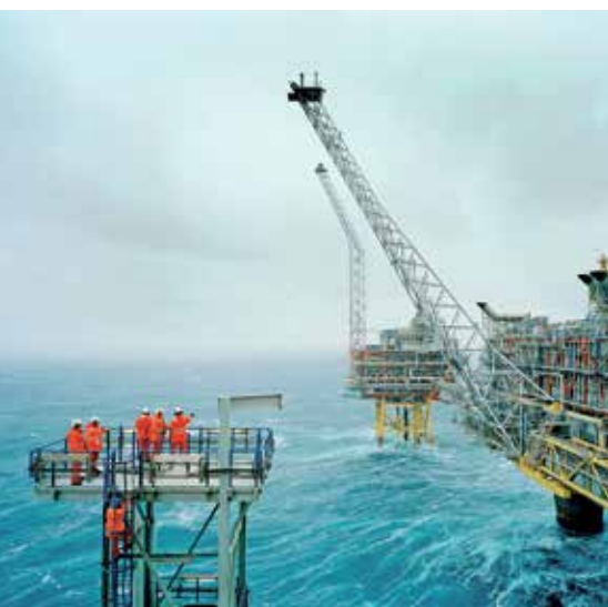
TRABALHOS EM PLATAFORMAS
